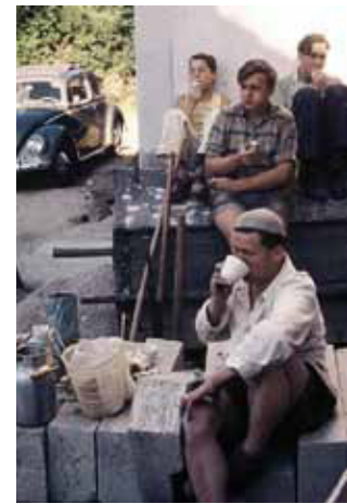
Bauarbeiter der Christuskirche.
