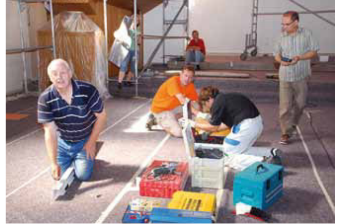
Renovierungsarbeiten in der Christuskirche, 2011.
